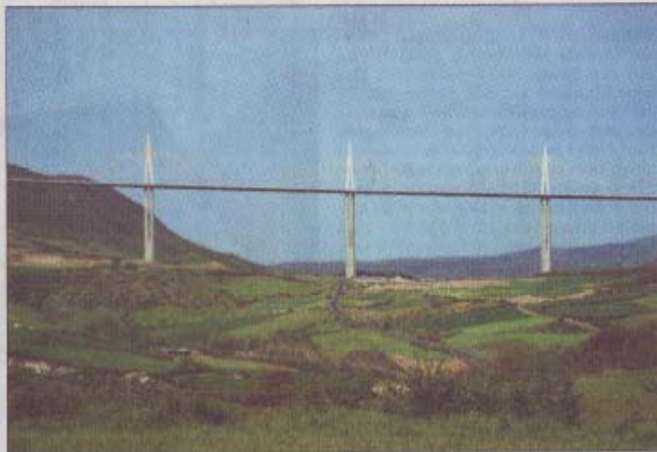
Eine rekordverdächtige Ingenieursleistung war der Bau des „Viaduc de Millau“ in Südfrankreich, der höchsten Brücke der Welt. Foto: Dillersberger Hütte
